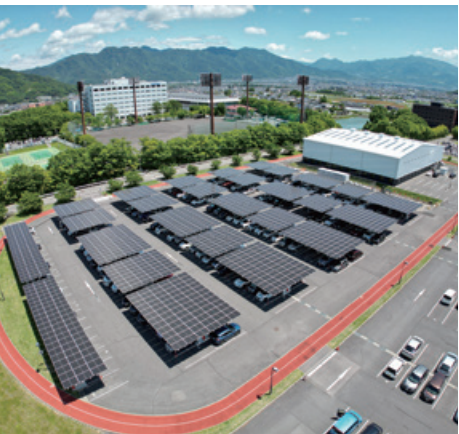
ソーラーカーポート第一期工事完了
