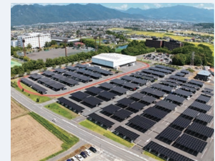
本社敷地内のソーラーカーポート
